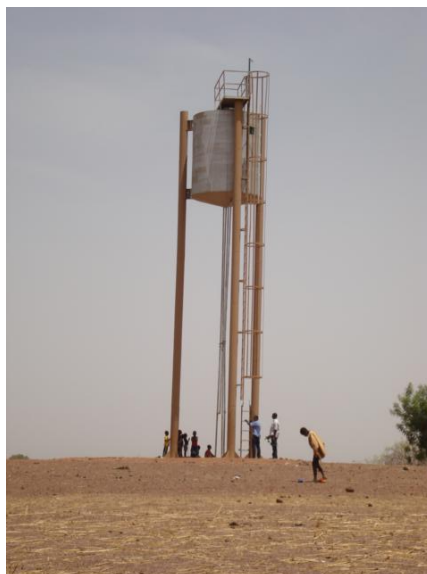
Abbildung 1: Wasserturm in Pathiri
